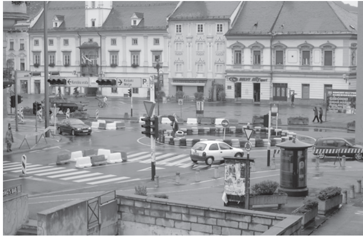
Sl. 3. Montažno trikrako, enopasovno krožišče na Koroški ulici v Mariboru Fig. 3. Montage three-armed, one-lane roundabout on Koroška Street in Maribor
