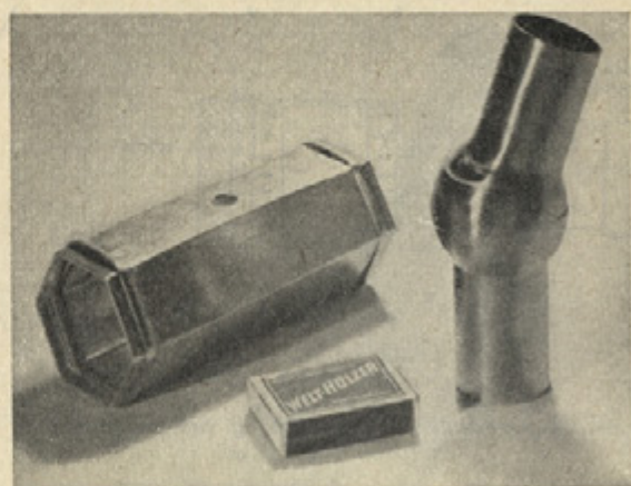
Sl. 18. Po hidroelektričnem postopku izdelani oblikovanci (BBC)
