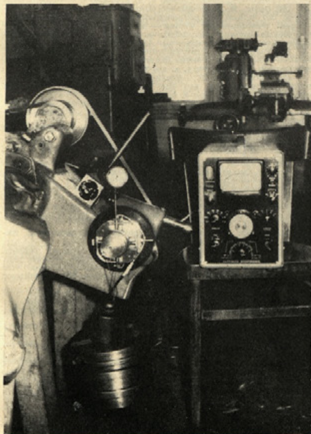
Sl. 9. Umerjanje dinamometra
