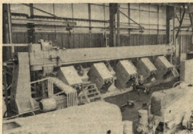
Sl. 11. Avtomat za kontinuirno kovaško valjanje (Eumuco A. G., Leverkusen)
